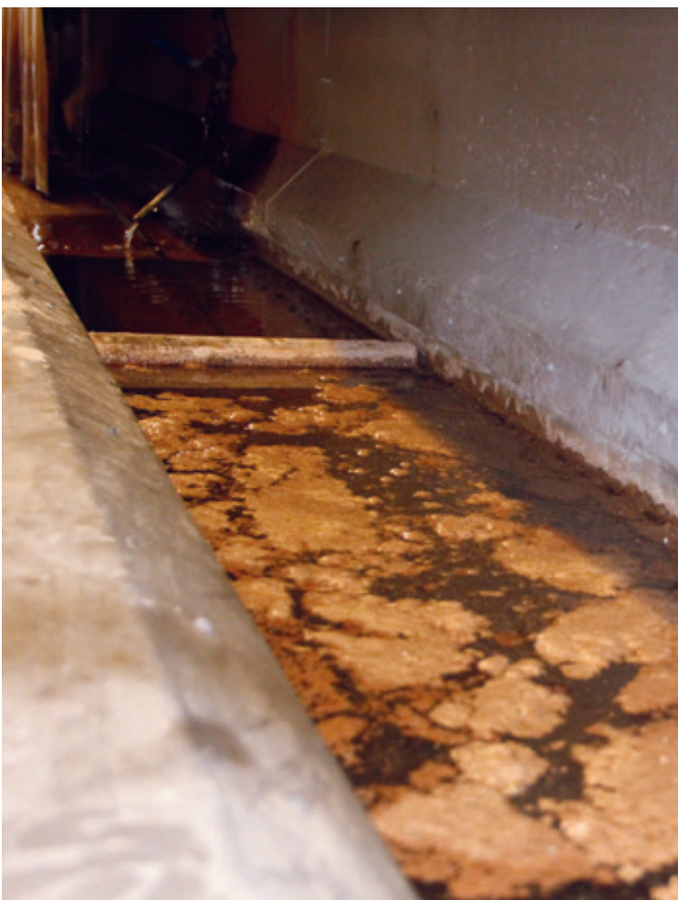
Abb. 7 – Kühlstraße mit ungenügend aufbereitetem Grundwasser (Kiesfilter)
